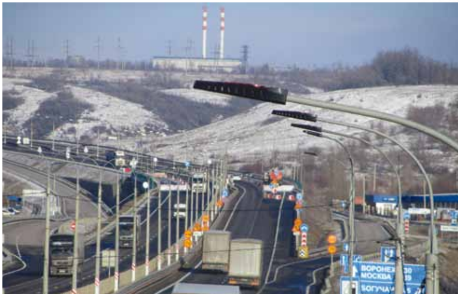
Освещение объездной дороги в Чите (светильники Superstreet со встроенной системой управления АСУНО ГОРСВЕТ, компания LEDEL)
